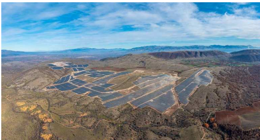
Το φωτοβολταϊκό πάρκο των 204,3 MW της HELLENiQ ENERGY στη Κοζάνη, αποτέλεσε έργο-ορόσημο για την ενεργειακή μετάβαση της χώρας
